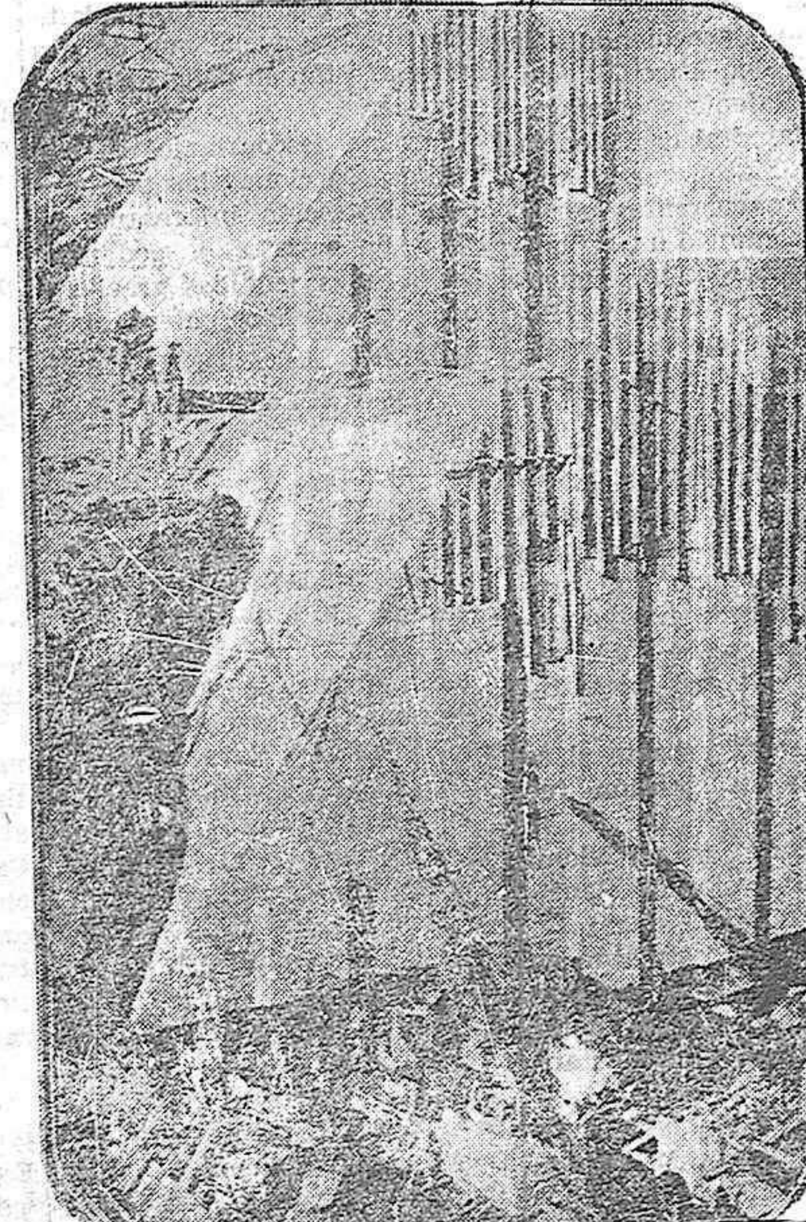
Estado actual de las obras de la presa
