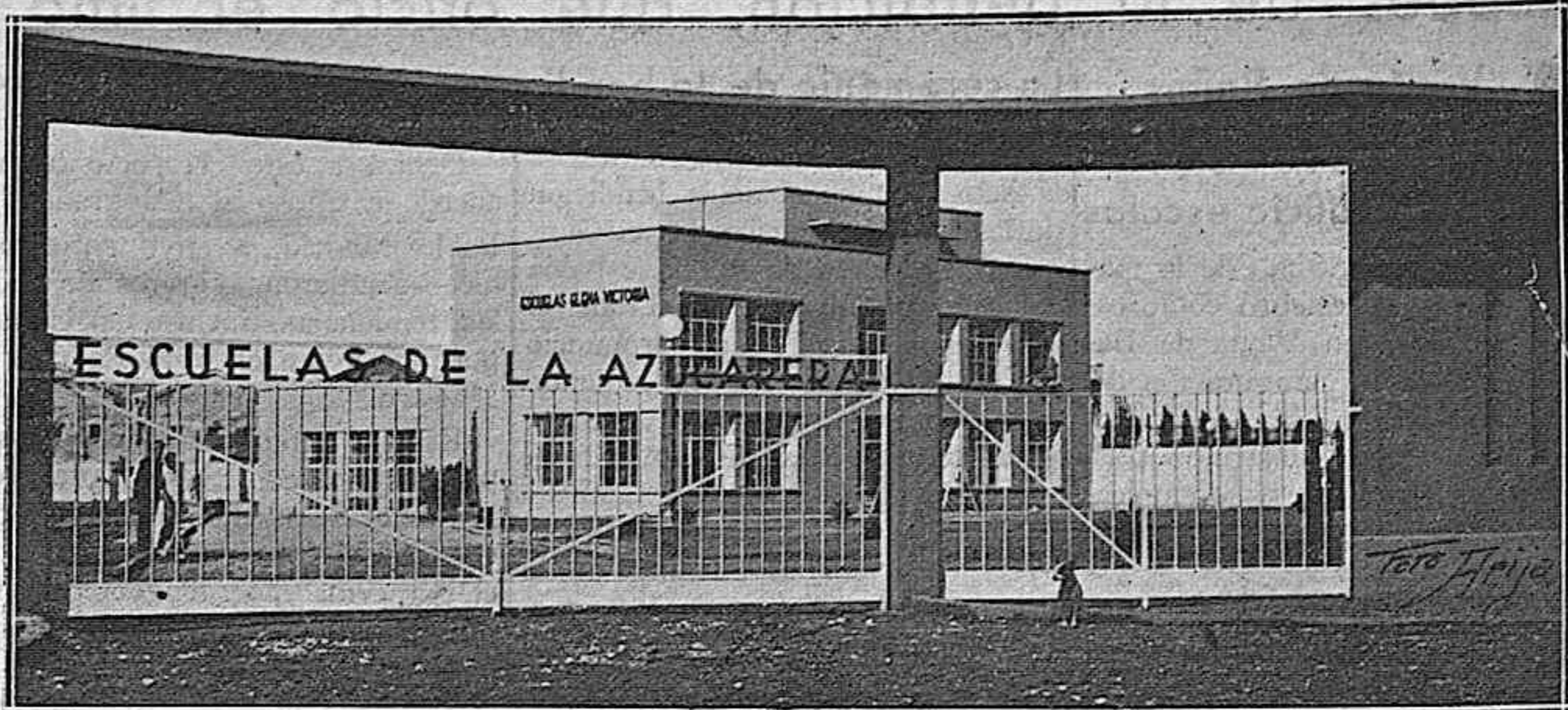
Vista general de las Escuelas de la "Azucarera de Castilla" inauguradas ayer en Venta de Baños
