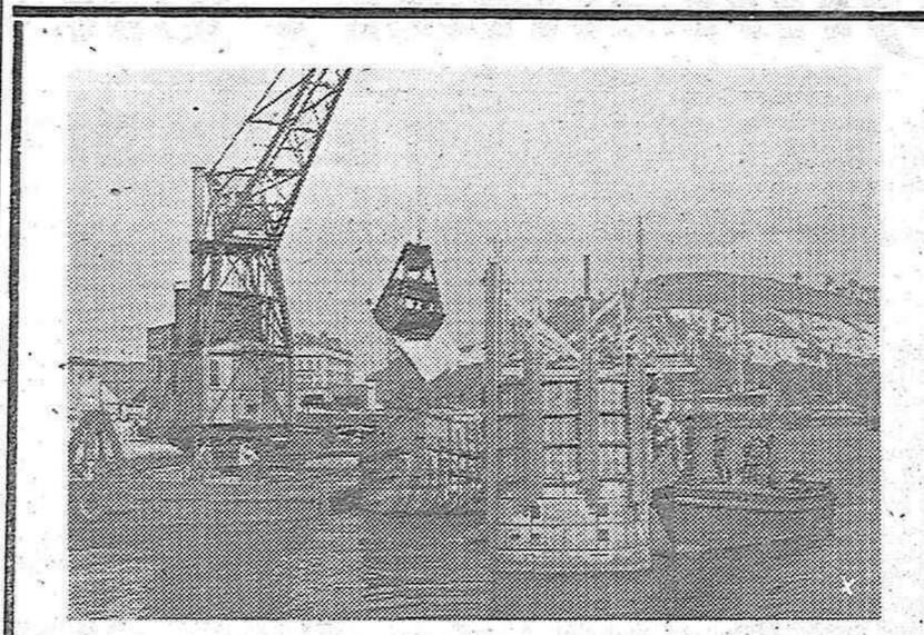
Grúas flotantes y dragas desembarazan las aguas del Sena de los restos de un puente volado por los aliados en Rouen
