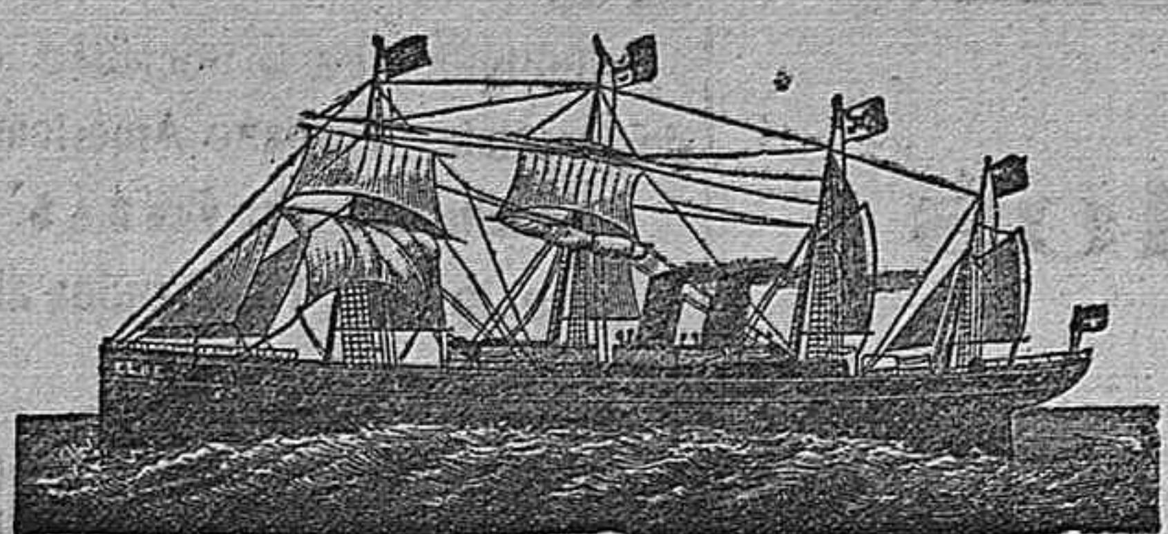
El nuevo y lujoso vapor correo, de 16.500 toneladas á dos máquinas y doble hélice provisto de telegrafía sin hilos y de todos los modernos adelantos
