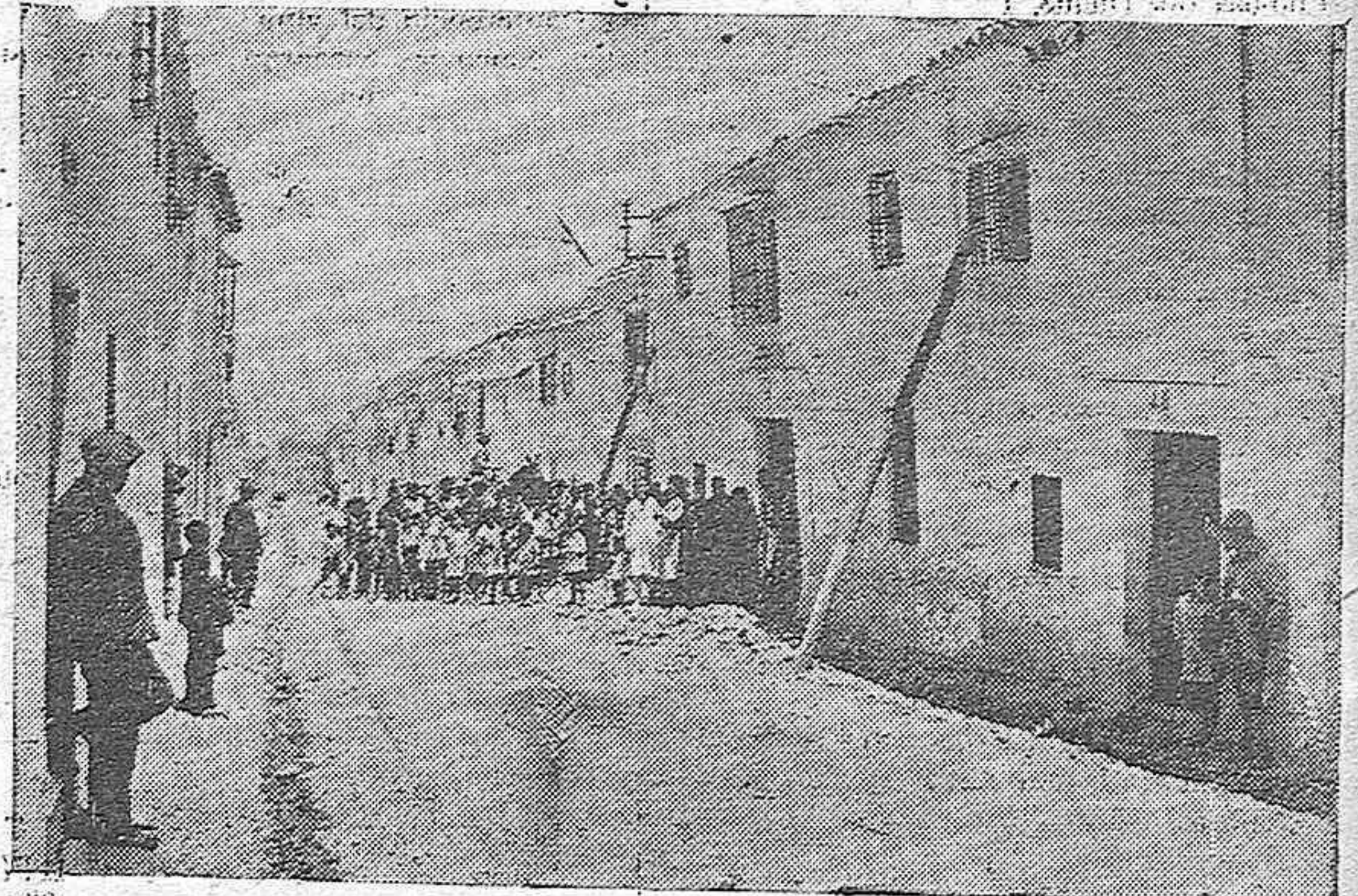
EL TERREMOTO EN MONTILLA.—LA CALLE DE SANTA BRÍGIDA, UNA DE LAS MÁS CASTIGADAS POR EL MOVIMIENTO SISMICO, Y QUE EN CASI SU TOTALIDAD SE ENCUENTRA CON ENORMES DESPERFECTOS.
