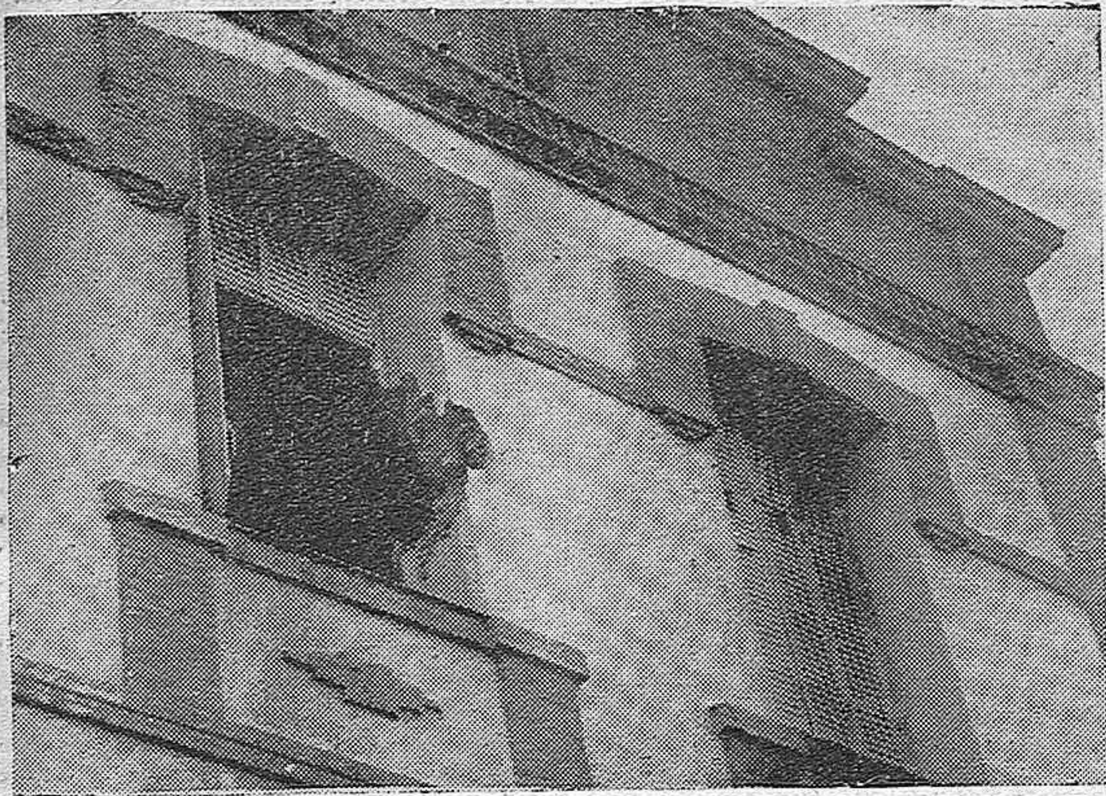
Destrozos causados en una ventana del Campamento de Cuatro Vientos por un proyectil de Artillería (Foto Alfonso.)
