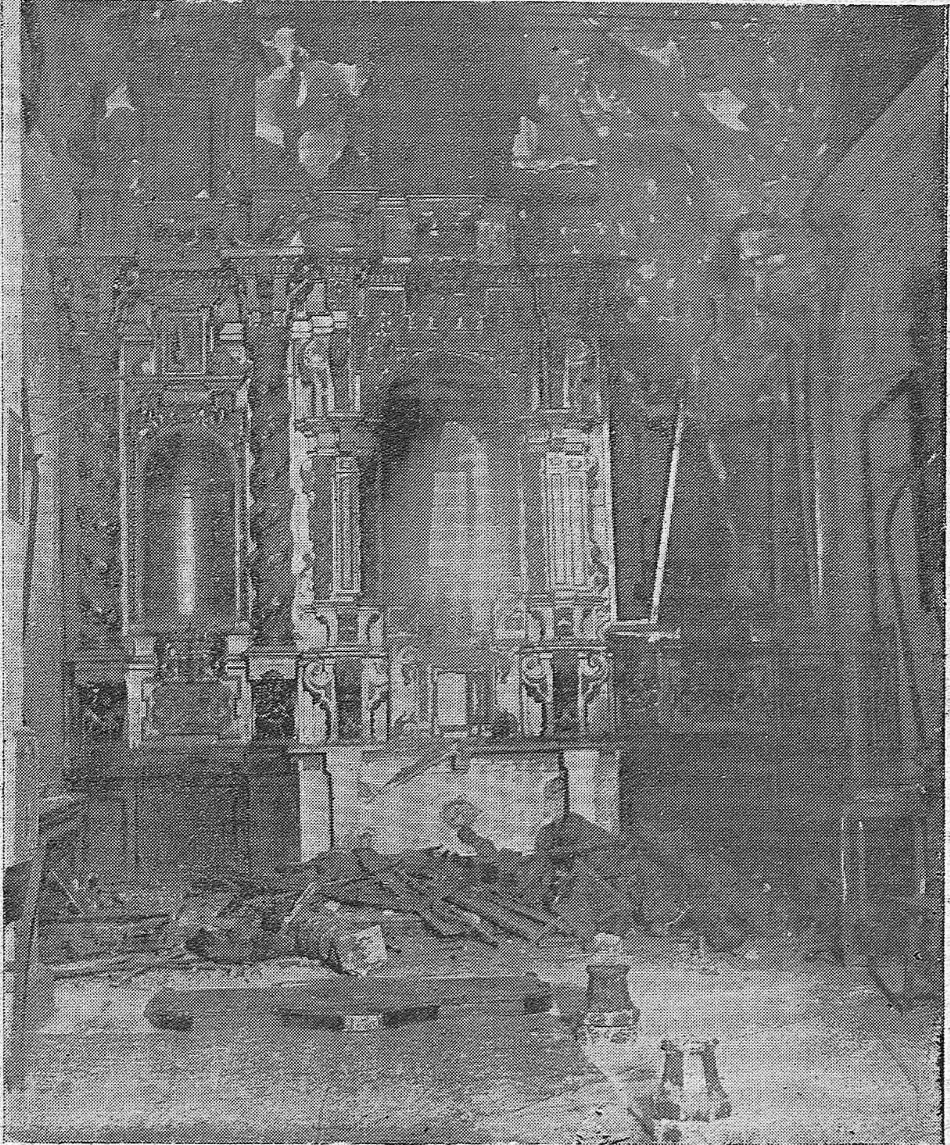
AGUILAR. Estado en que quedó la capilla del Asilo de Ancianos de dicho pueblo, que fué destruida por un incendio.
