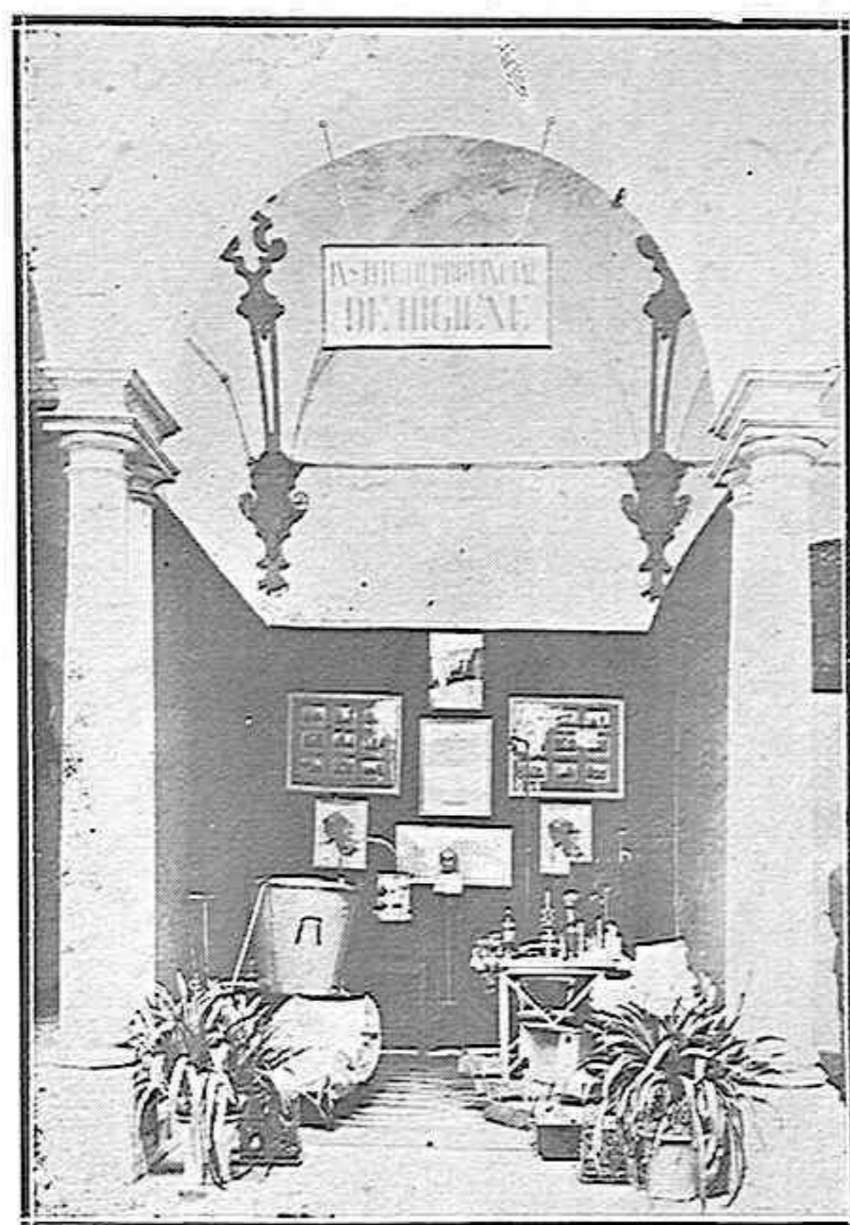
Instalación del Instituto provincial de Higiene
