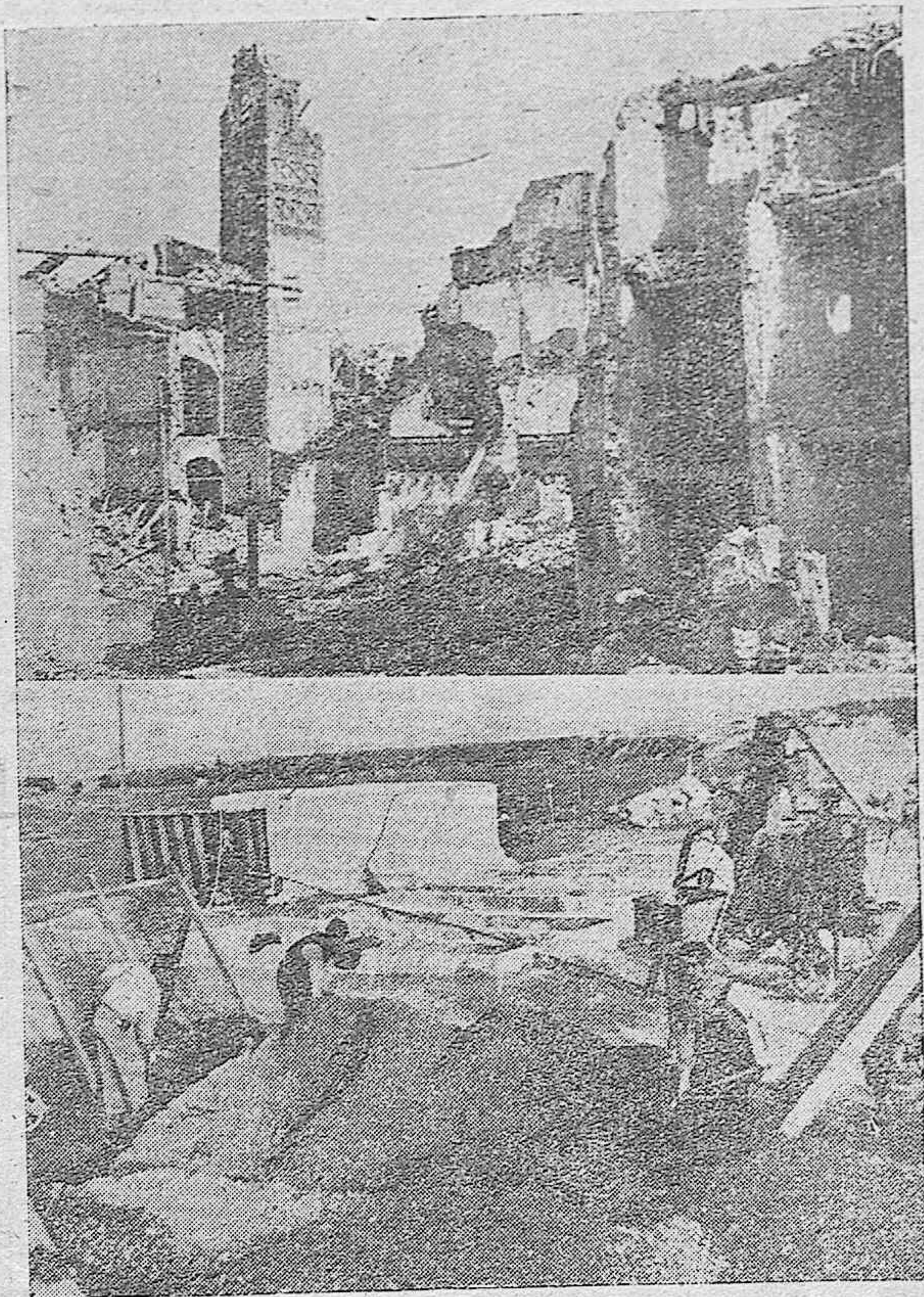
Así se encuentra la ciudad mártir de Belchite. Las ruinas gloriosas se están respetando, y empieza la construcción de la nueva ciudad. Los prisioneros de guerra trabajan en la fabricación de materiales para la reedificación.
