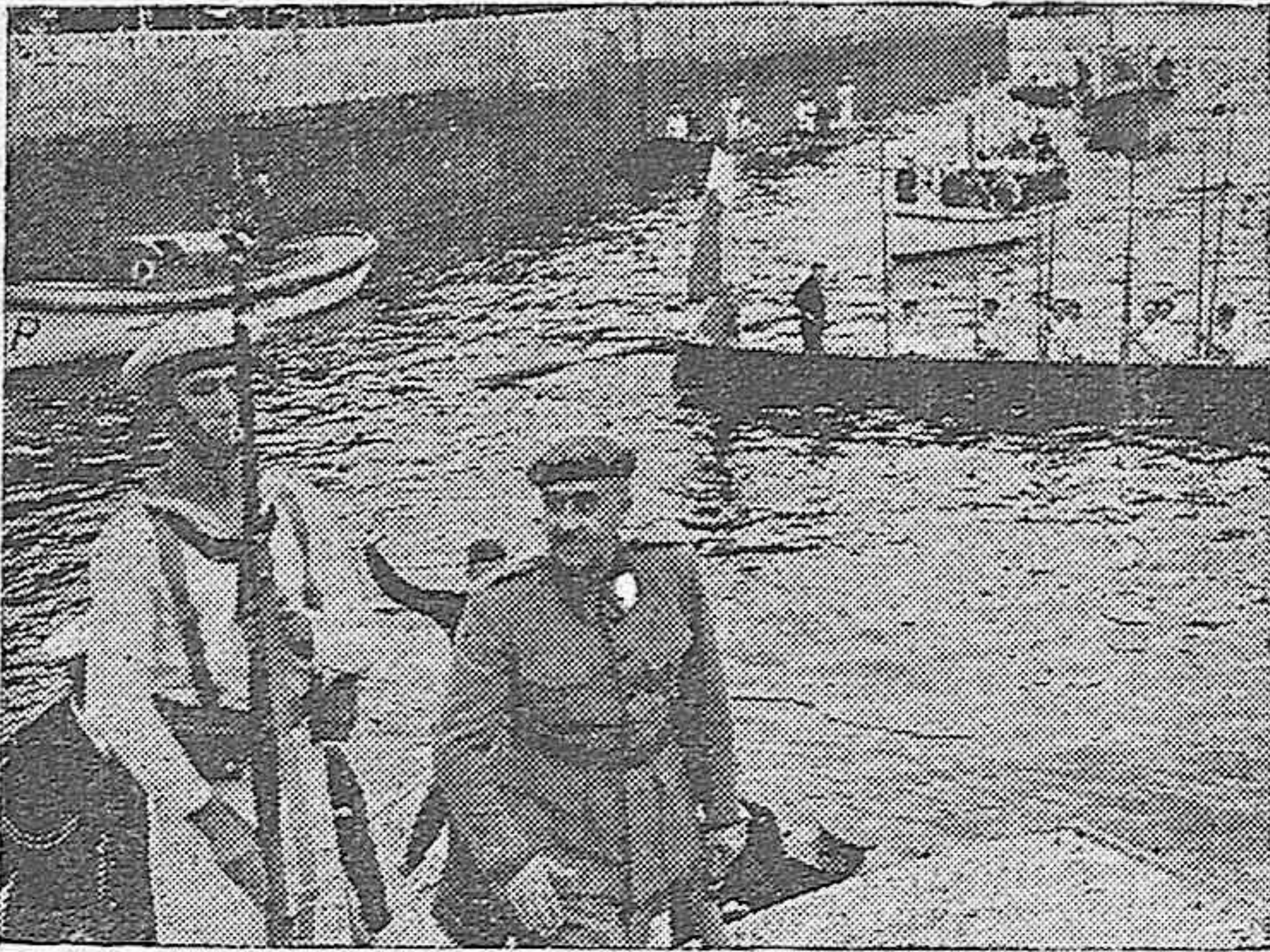
S. E. desembarcando de la gasolinera en que recorrió el puerto de Pasajes, durante su visita a las obras del mismo.
