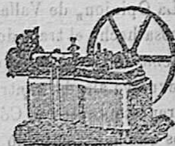
Máquina de vapor Horizontal.
