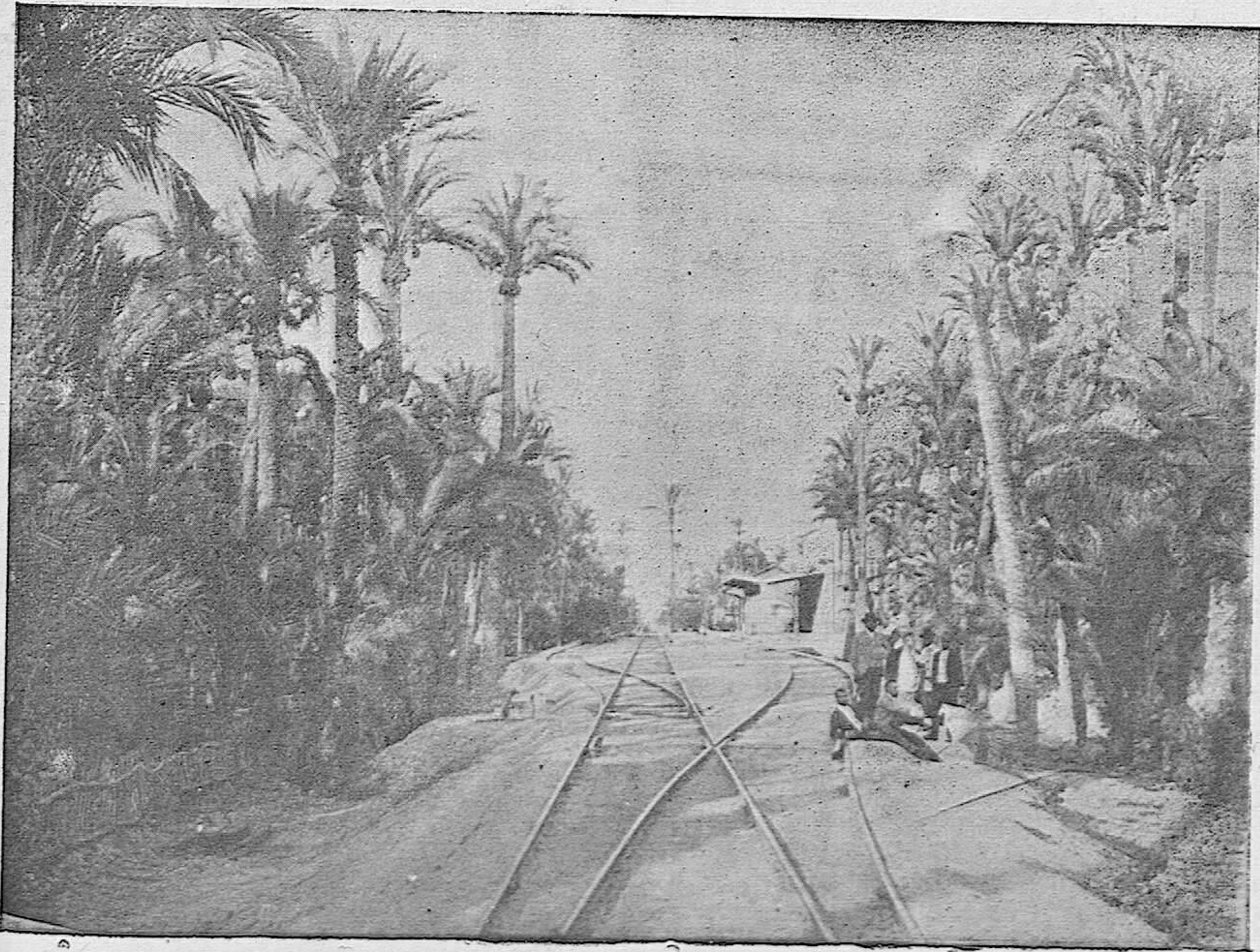
UNA VISTA DE LA ESTACION DE ELCHE
