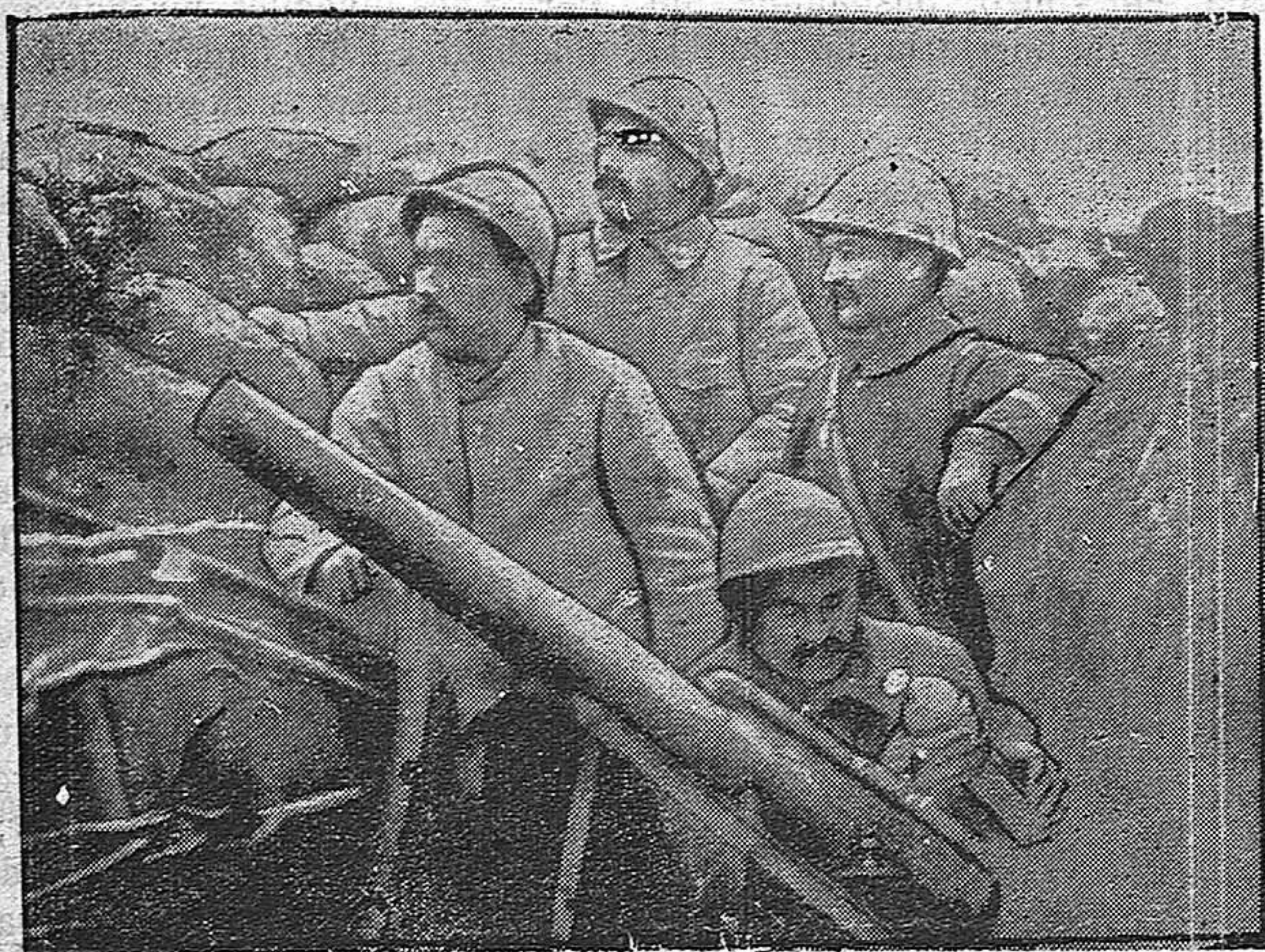
Cañón de trinchera
