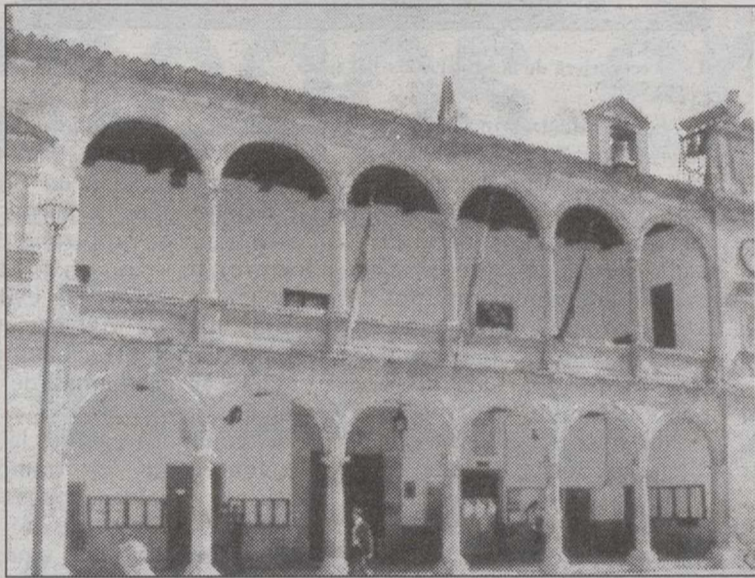
Traslado de servicios del Ayuntamiento de Villarrobledo.
