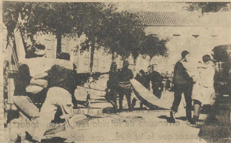
En plena actividad, tras el "incendio" en el Colegio de Escuelas Pías, los bomberos, Cruz Roja y otros servicios, proceden a la recogida y evacuación de supuestos heridos, para conducirlos al puesto de socorro más próximo. (Fotos RAFAEL).
