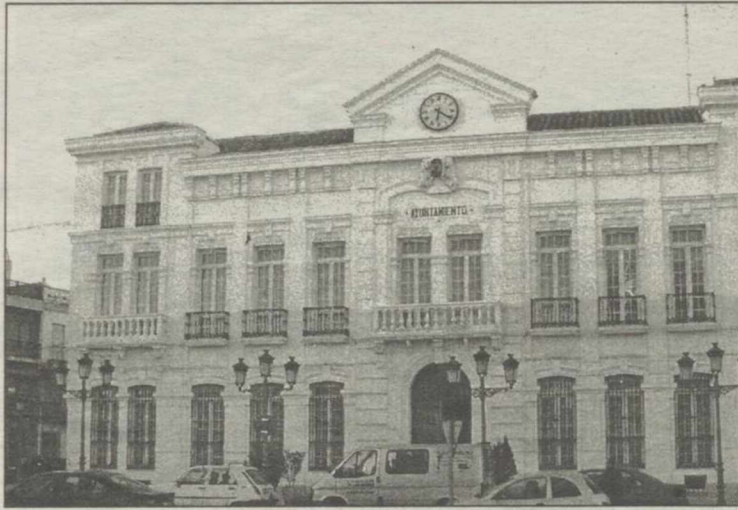
Fachada del Ayuntamiento tomellosero
