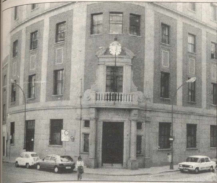
La lista para la instalación de teléfonos es mínima
