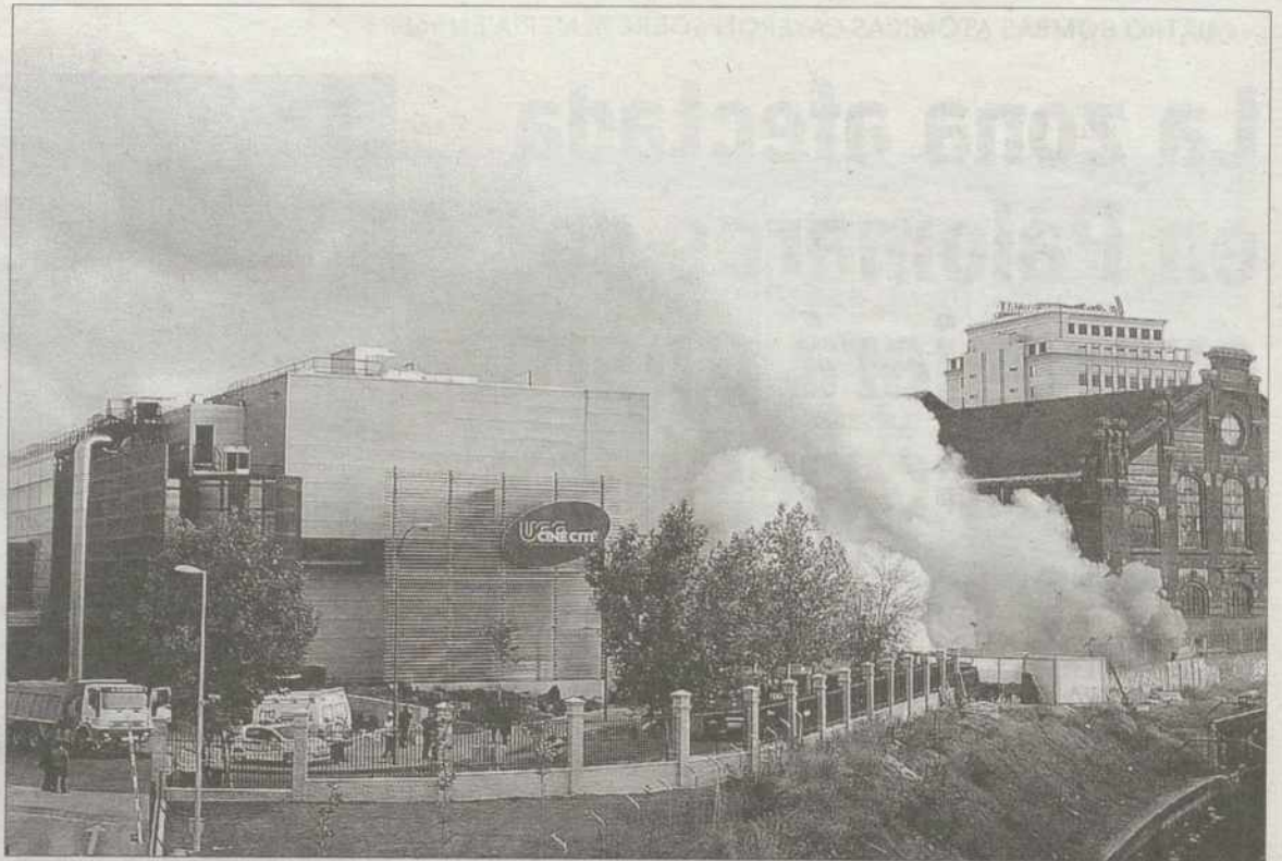
La columna de humo originada por la combustión del aceite refrigerador de la subestación era visible en todo Madrid. / EFE
