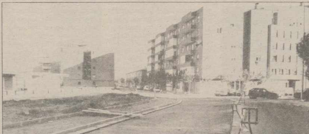
Vista de la calle Los Olmos en obras
