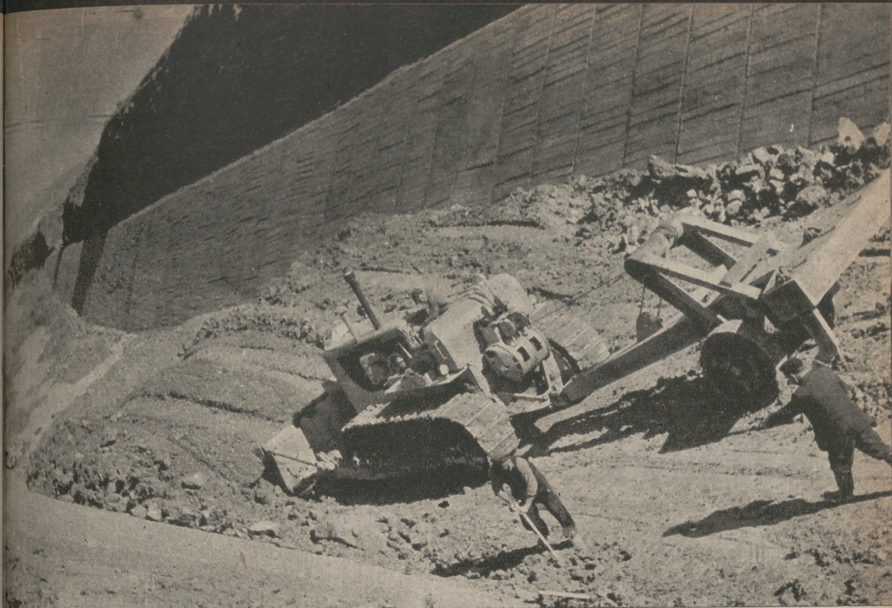
Potentes máquinas se emplean en el trazado del canal de Las Bardenas
