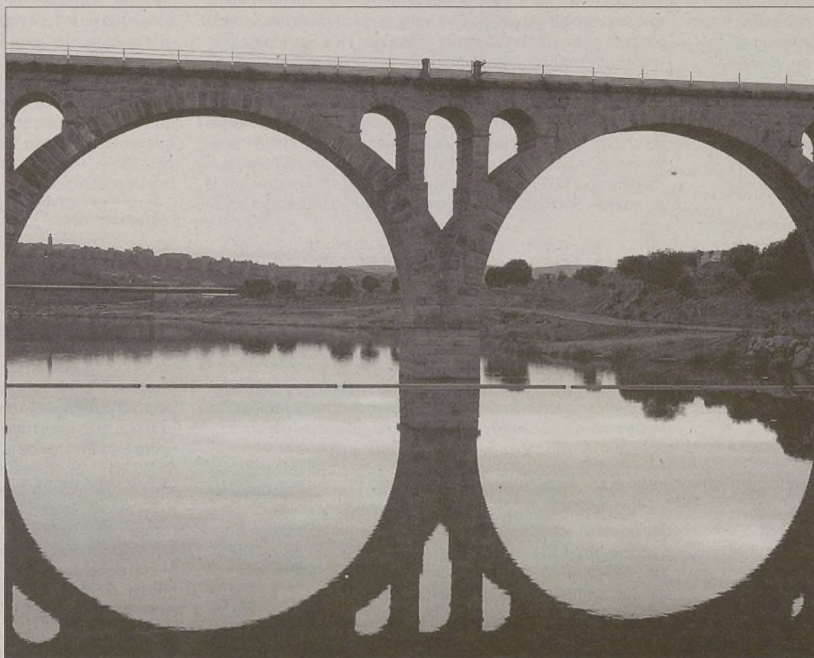
Embalse de Fuentes Claras, cuya agua se sigue bombeando a la Estación de Tratamiento de Agua Potable.
