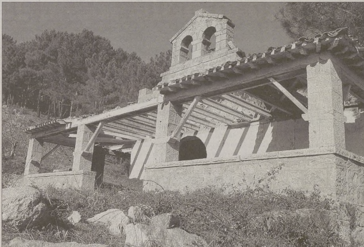
Imagen del estado actual en que se encuentra la ermita de Las Majadas, que será rehabilitada próximamente. / DAVID MARTÍN
