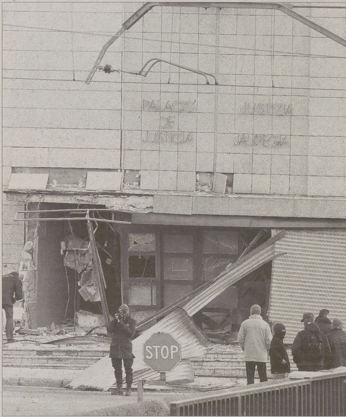
La bomba causó numerosos daños en la puerta principal de los juzgados de Balmaseda, en Vizcaya. / EFE
