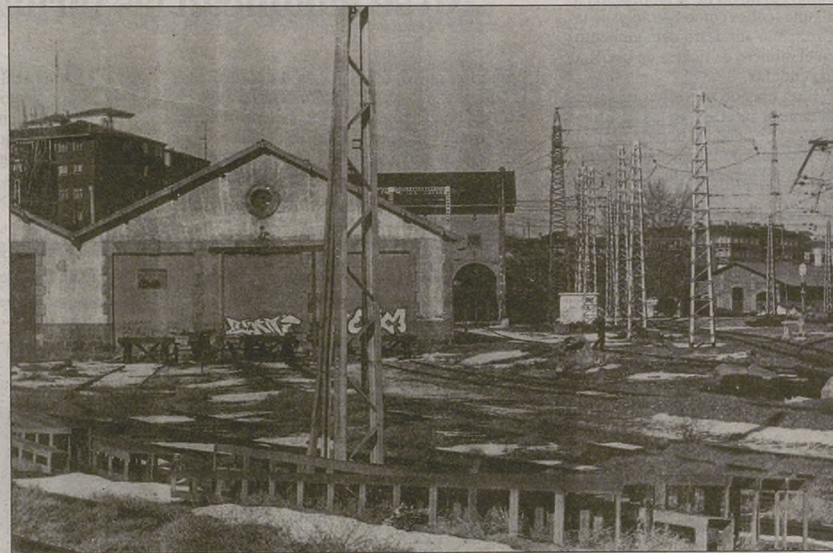
Las naves se encuentran al sur de las vías ferroviarias que se utilizan / LUMBRERAS
