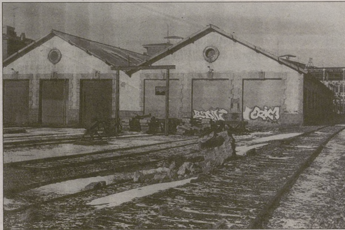
Vista de las dos naves cedidas por Renfe al Ayuntamiento / LUMBRERAS
