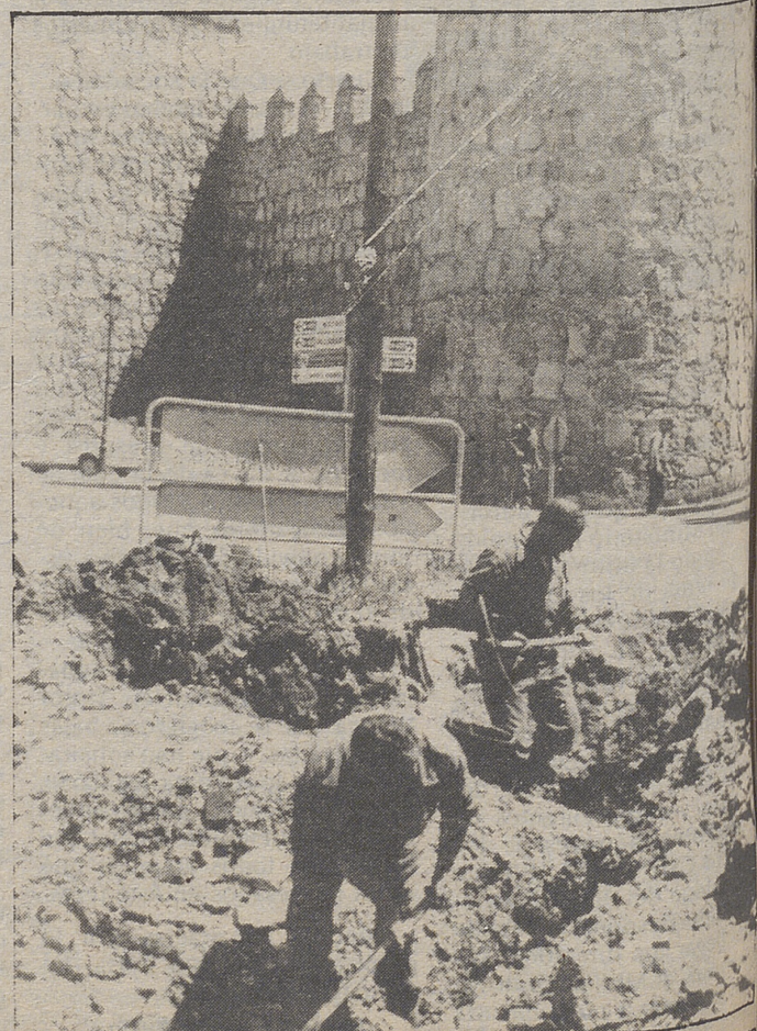
Una avería en la conducción de agua, en el puente Adaja, dejó sin abastecimiento a una zona del sector de la ciudad.
