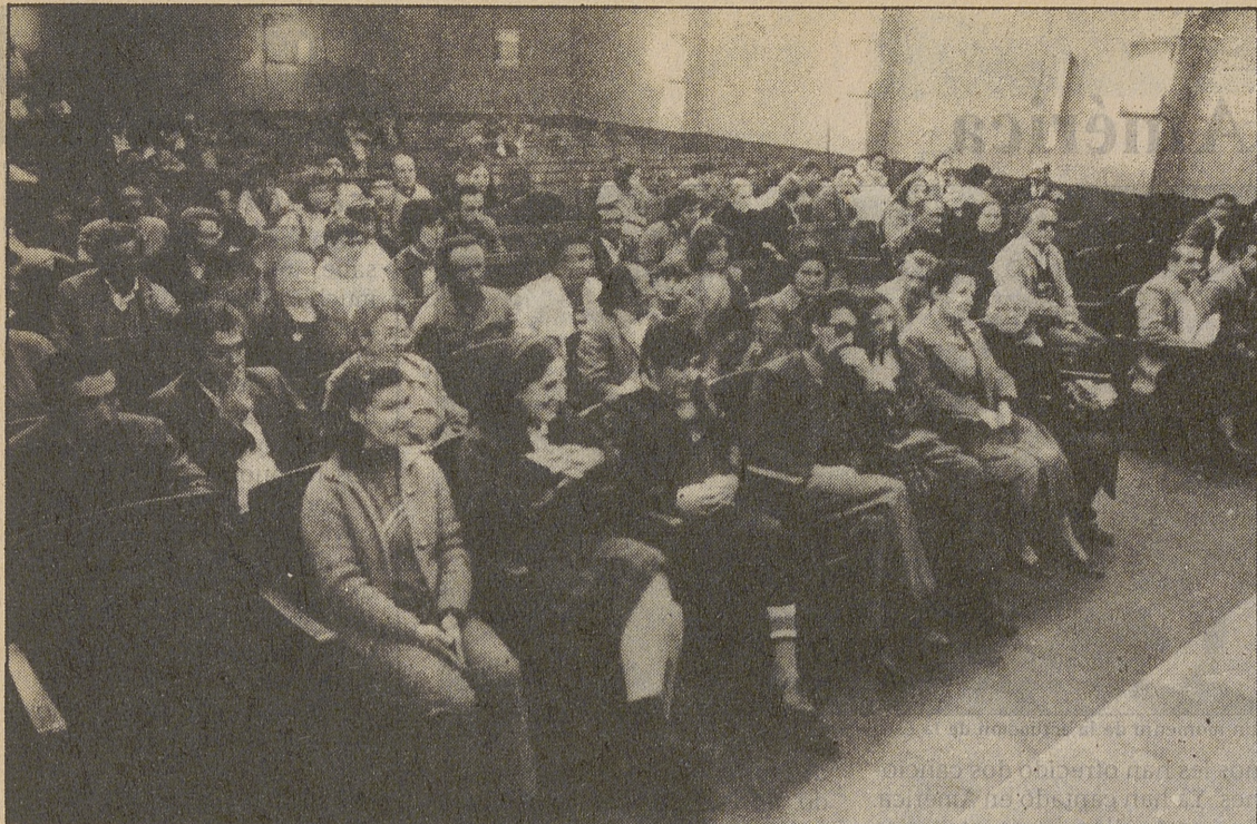
Cincuenta y seis familias ocuparán las viviendas de la Avenida de la Juventud LUMBRERAS
