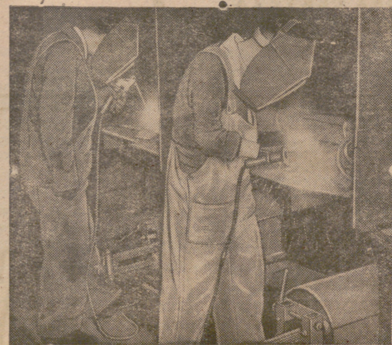
Obreros mancos aprendiendo a soldar eléctricamente en los talleres del Colegio Queen Elizabeth de Londres
