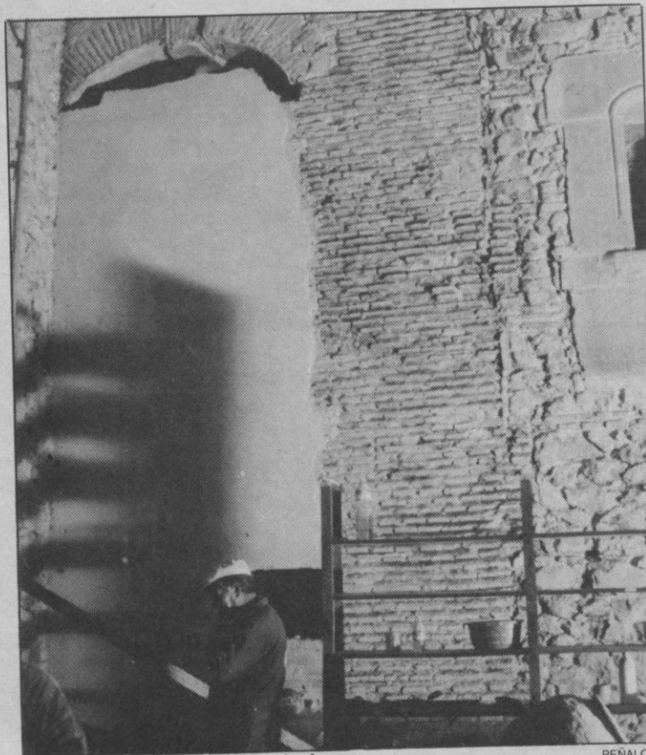
Obras de mejora de las instalaciones.
