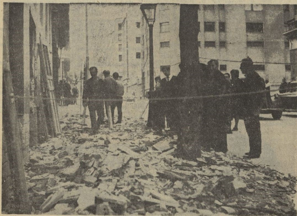
Los restos de la cornisa cuya caída produjo graves heridas a un obrero que se disponía a subir a un andamio
