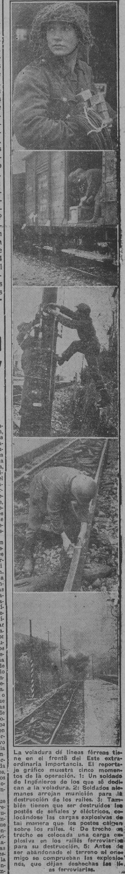
La voladura de líneas férreas tiene en el frente del Este extraordinaria importancia. El reportaje gráfico muestra cinco momentos de la operación: 1. Un soldado de ingenieros de los que se dedican a la voladura. 2. Soldados alemanes arrojan munición para la destrucción de los raíles. 3. También tienen que ser destruidos los postes de señales y eléctricos, colocándose las cargas explosivas de tal manera que los postes caigan sobre los raíles. 4. De trecho en trecho es colocada una carga explosiva en los raíles ferroviarios para su destrucción. 5. Antes de ser abandonado el terreno al enemigo se comprueban las explosiones, que dejan deshechas las líneas ferroviarias. (Foto Transocean.)
