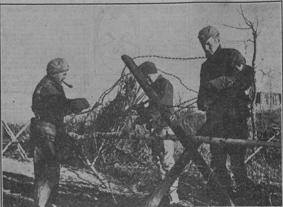
Soldados alemanes de las brigadas de Ingenieros colocando alambradas que servirán de obstáculo ante el avance del enemigo. Como puede apreciarse en el grabado, estos soldados trabajan con manoplas de gran protección para evitar los arañazos y heridas profundas en las manos ocasionados por los pinchos de las alambradas. (Foto Victor.)
