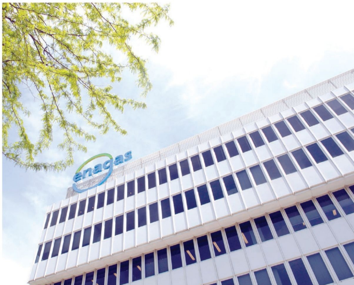
Edificio de la sede principal del gestor gasista Enagás en Madrid.
