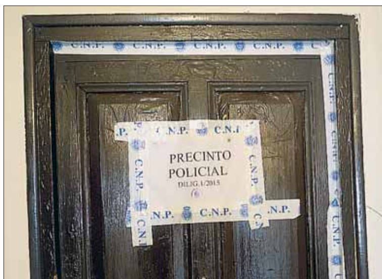
La puerta de entrada a la vivienda siniestrada, precintada por la policía. / KAMARERO
