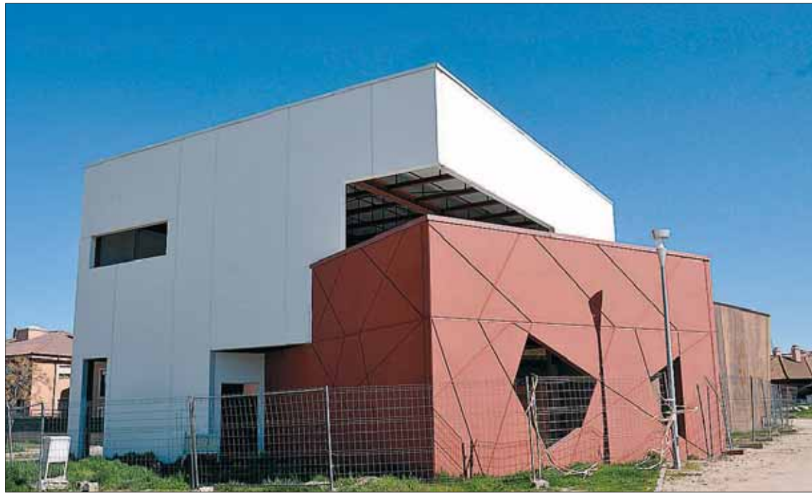
Estado actual del futuro centro de usos múltiples de Torrecaballeros. / JUAN MARTÍN
