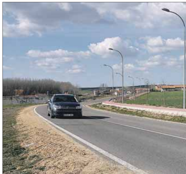
El Servicio de Obras está a punto de iniciar el refuerzo del firme de la carretera de Hontanares...
