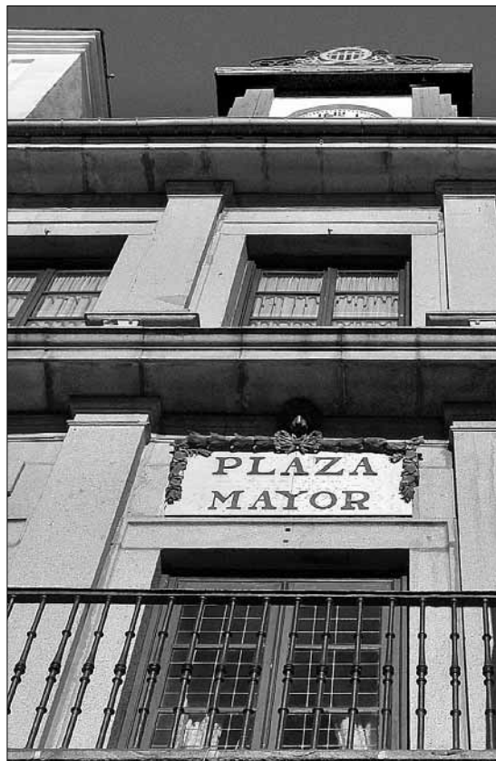
Fachada del edificio principal del Ayuntamiento de Segovia. / KAMARERO
