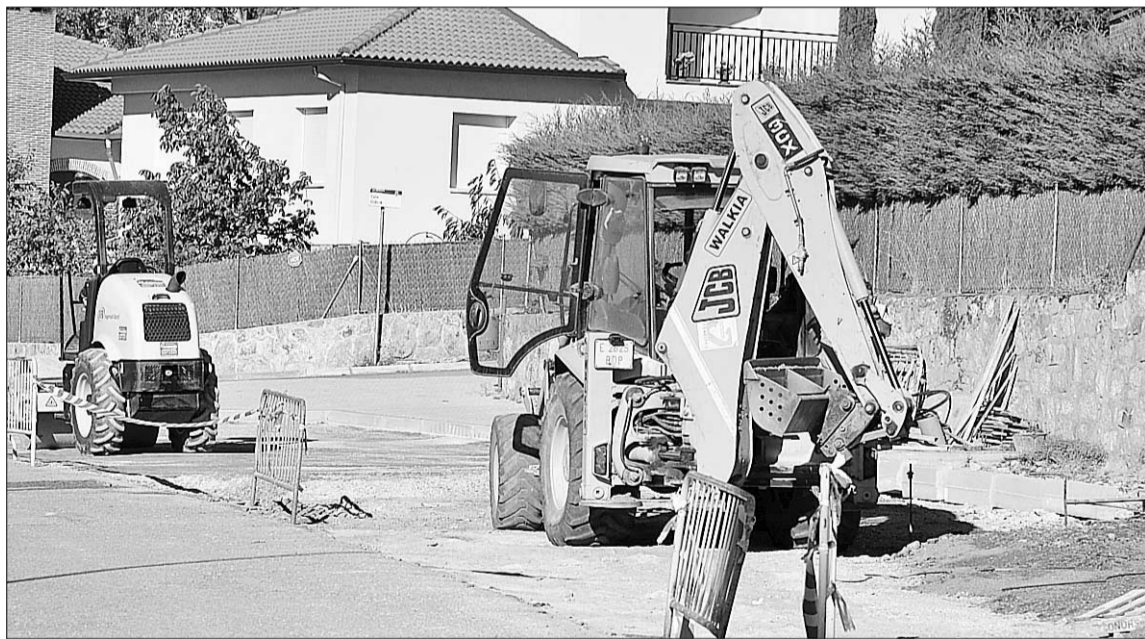
Imagen de las obras que se están realizando en los aparcamientos de La Estación de El Espinar. / P. L. MERINO
