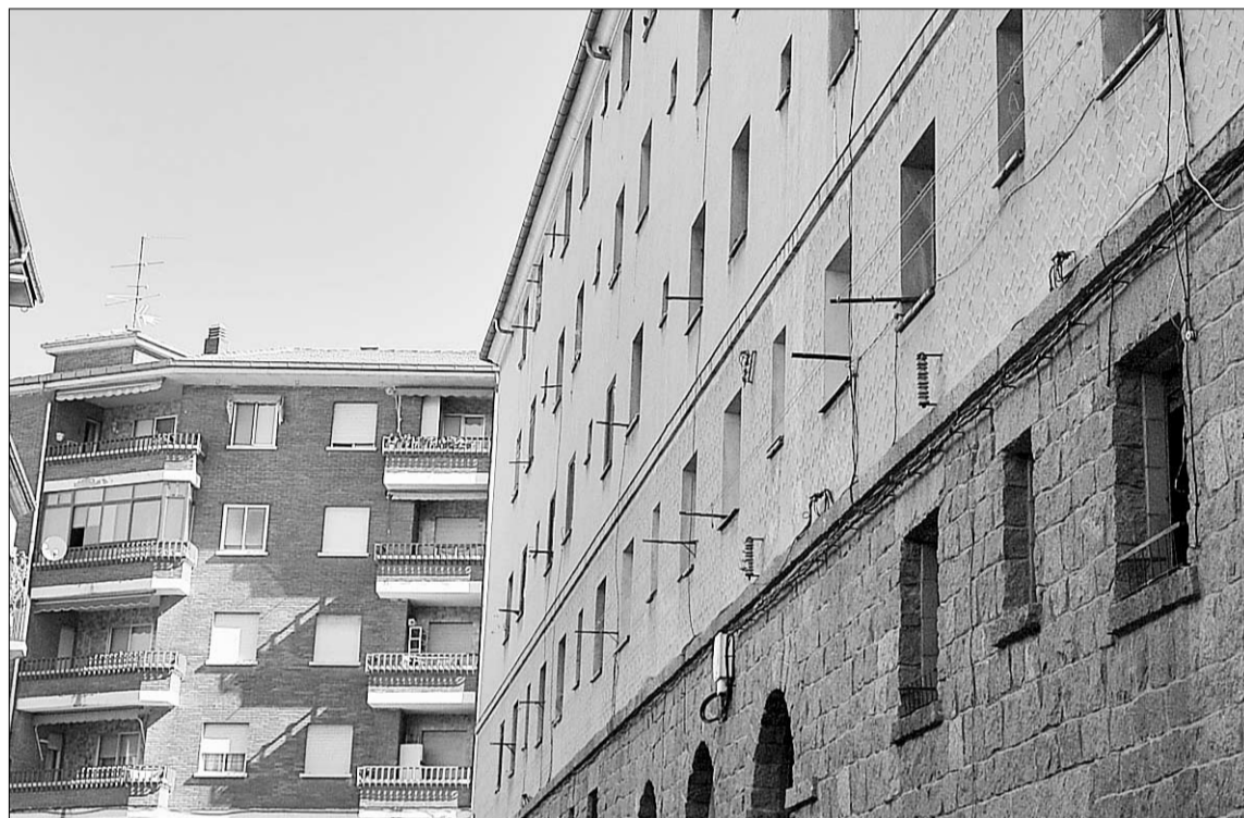
Los propietarios contarán con un plazo de un año para solucionar todas las deficiencias que detecte la inspección. /KAMARERO
