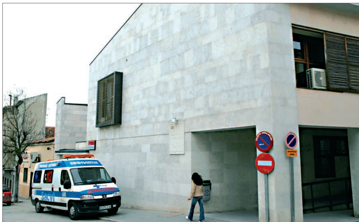
Actuales instalaciones del Centro de Salud de la villa./ GABRIEL GÓMEZ
