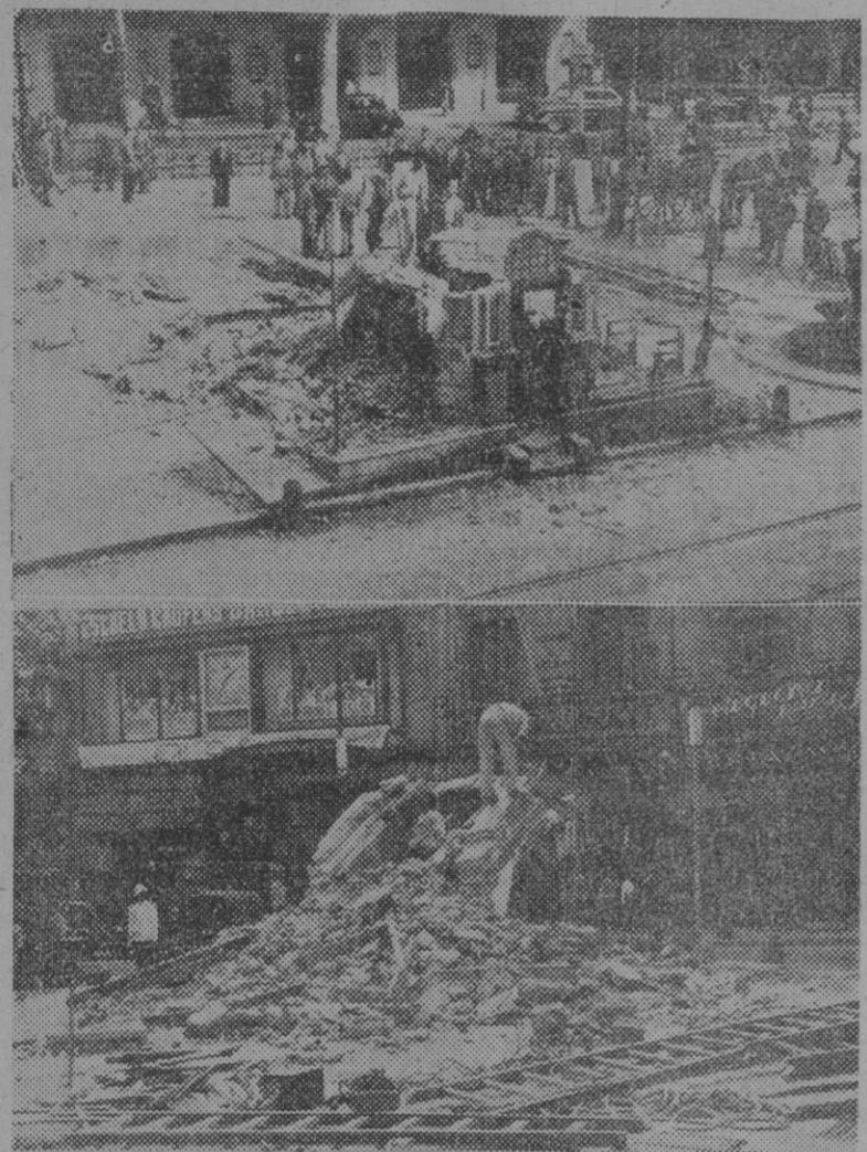
Ha sido derribado el quiosco de Canaletas. Estas dos fotografías recogen los últimos momentos de la demolición. — (Fotos P. de Rozas)
