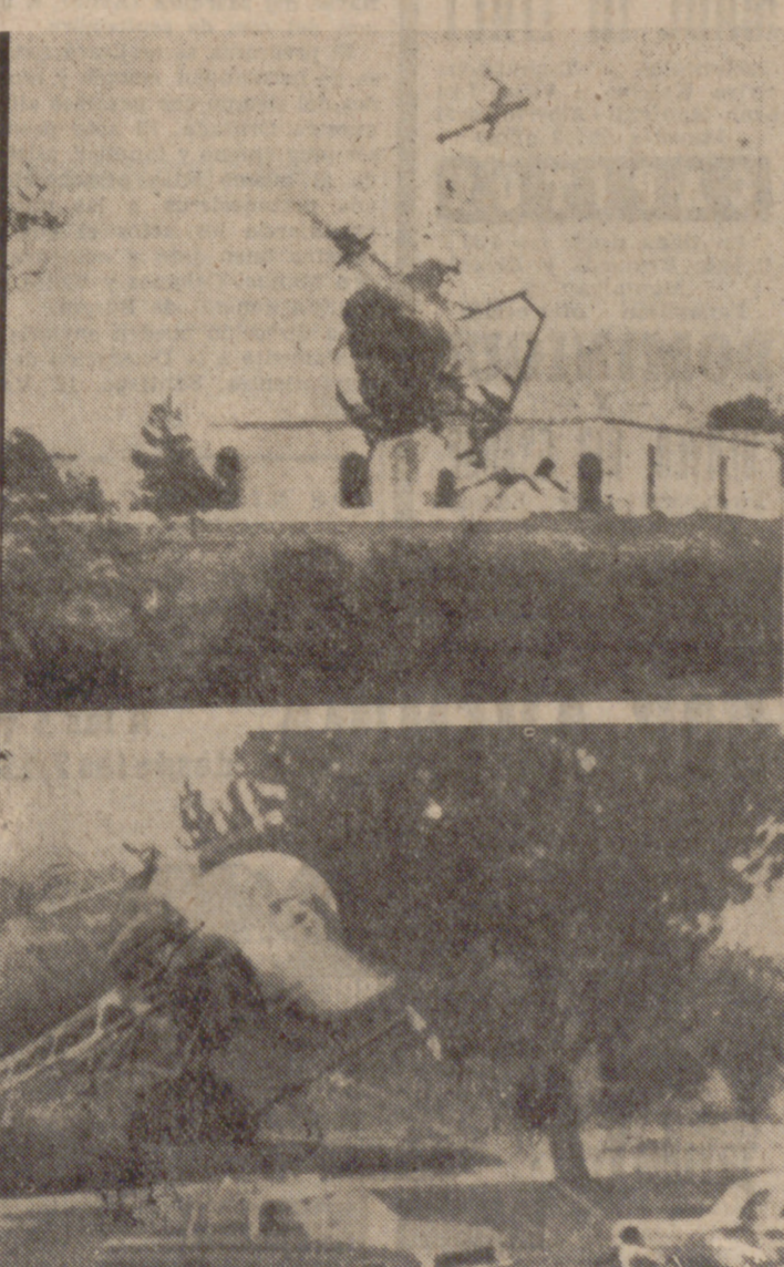
HOLLYWOOD.—Las fotografías muestran dos momentos del trágico accidente que costó la vida a dos personas cuando se trataba de reparar la veleta de una iglesia. El cable en el que iba suspendido un obrero se enrolló en la veleta, el helicóptero perdió el control y arrastró a tierra al obrero y al piloto, que resultaron muertos.—(Telefoto Upi-Cifra.)
