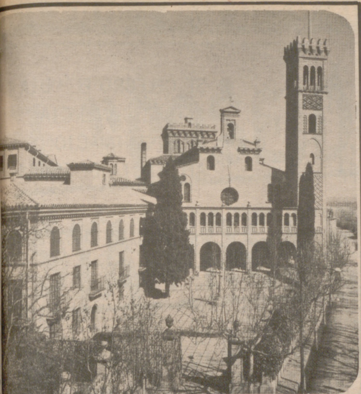
En este palacete de Cogullada antiguo monasterio zaragozano bellamente restaurado por la Caja de Ahorros de Zaragoza se alojarán los Príncipes de España durante los días del Pilar que pasarán en nuestra ciudad.
