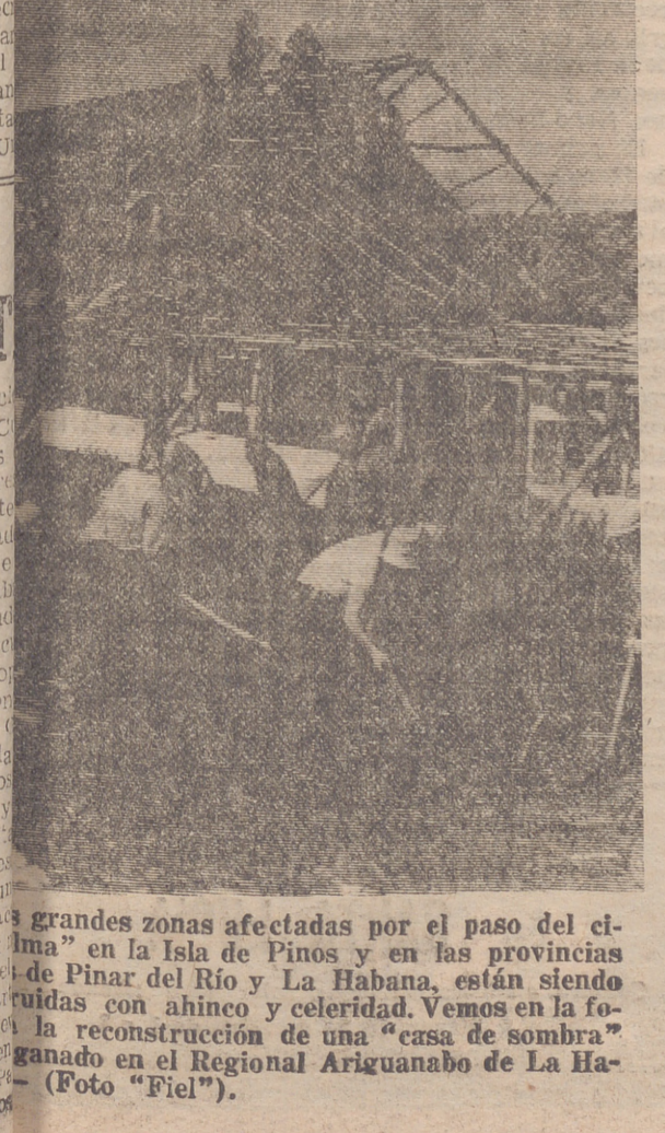
grandes zonas afectadas por el paso del ciclón «Alma» en la Isla de Pinos y en las provincias de Pinar del Río y La Habana, están siendo reconstruidas con ahínco y celeridad. Vemos en la foto la reconstrucción de una «casa de sombra» ganada en el Regional Ariguanabo de La Habana.—(Foto "Fiel").
