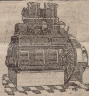
Su puesta en marcha es sencillísima completamente en frío, sin necesidad de medio auxiliar alguno de ignición, por manivela y sin esfuerzo en potencias hasta 28 HP. y por aire comprimido en las mayores.
