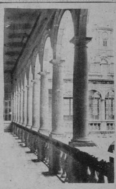
Galería superior del patio
