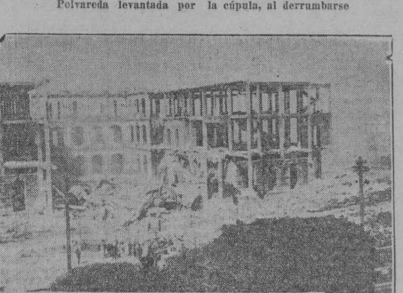
Después de la explosión
