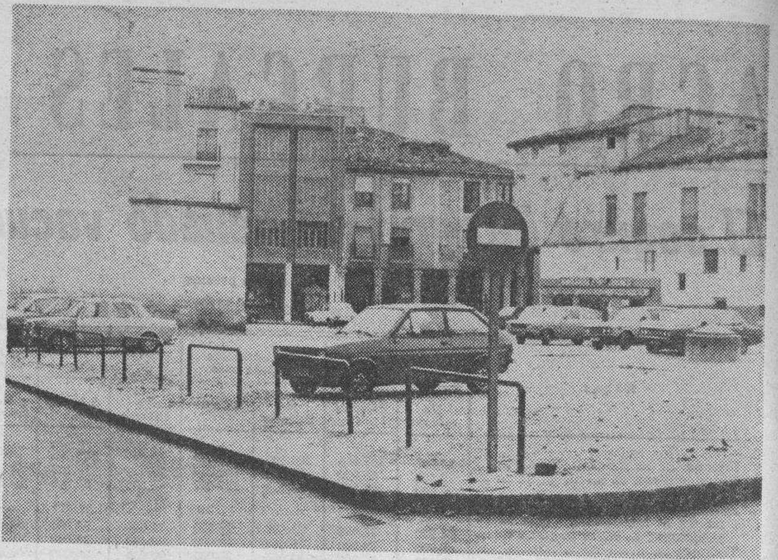
El solar de la Plaza del Trigo donde habrá de levantarse la futura Casa de Cultura y cuyo cerramiento ha sido aprobado por un valor de 552.370 pesetas. (Foto Florentino Lara)
