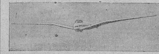
EN LA FOTOGRAFIA PUEDE VERSE EL ENÚMERO NUESTRO MODELO DE PLANEADOR BRITANICO, PROVISTO DE TREN DE ATERRIZAJE DE RUEDAS Y FRENSO DE PIGADO. TIENE UNA ENVERGADURA DE ALAS DE 19,9 Y UNA LONGITUD DE 3,25 Y PESO 300 KILOS VACIO. LA VELOCIDAD DE SUSTENTACION ES DE 50 KILOMETROS POR HORA Y LA MAXIMA POSIBLE QUE PUEDE ALCANZAR ES DE 210 KILOMETROS POR HORA.— (Foto Calpe)
