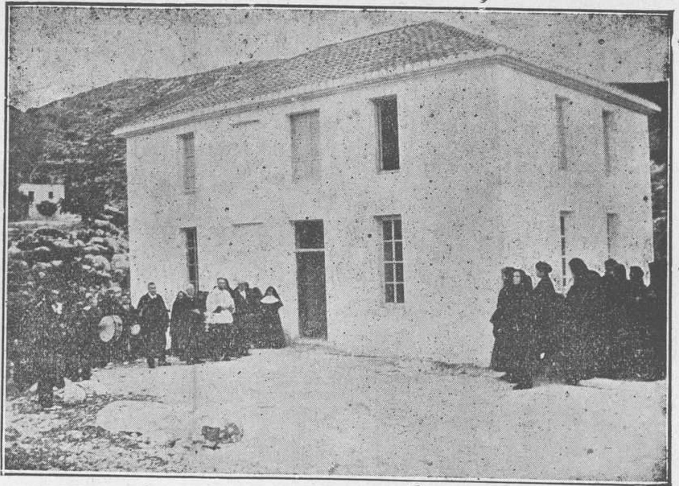
Bendición de la Granja avícola Pabellón de los enfermos encargados de su funcionamiento Fachada anterior
