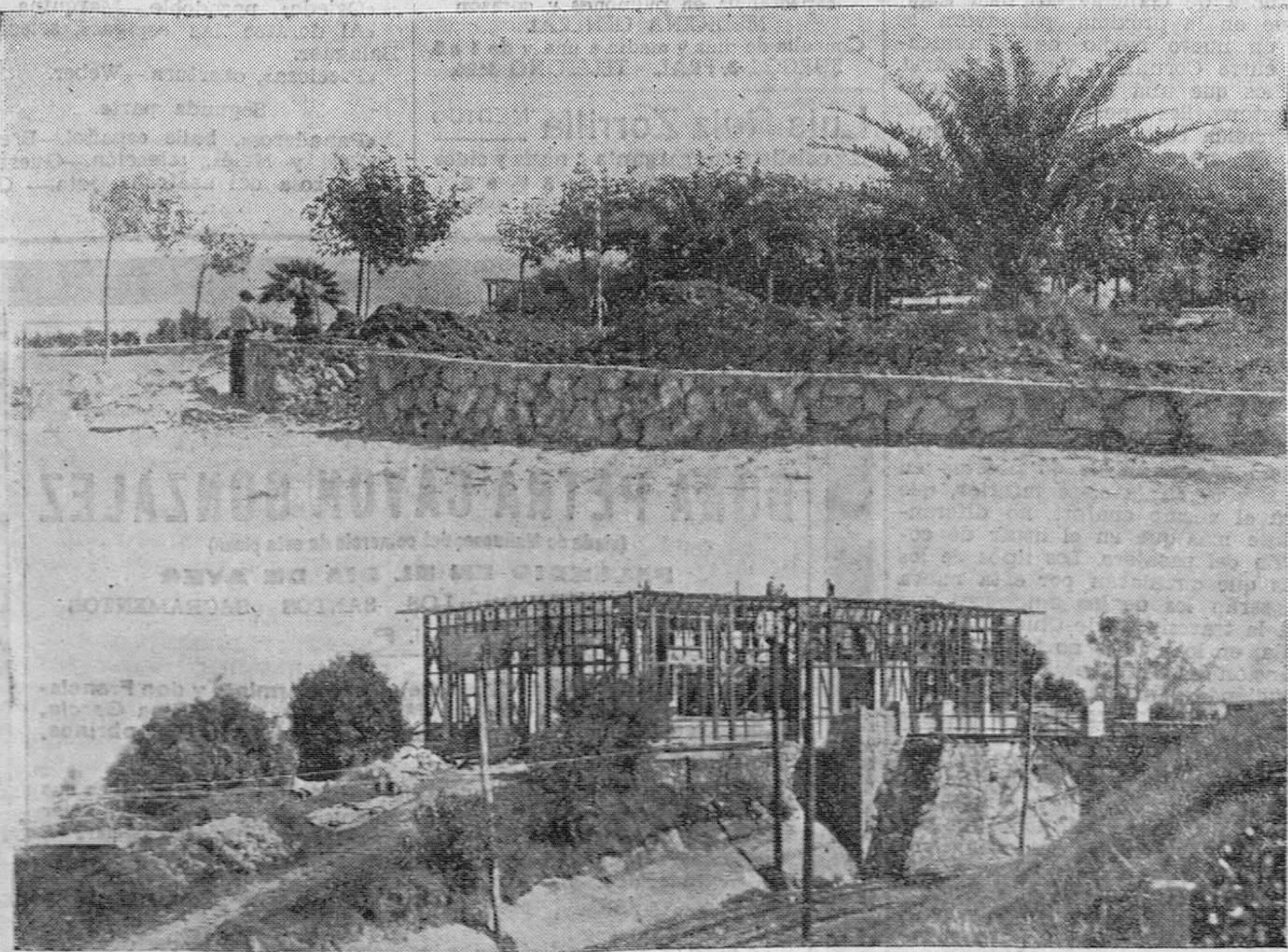
En el Sardinero, aunque lentamente, continúan las obras de reforma en la plaza de las Brisas, y avanza la demolición del antiguo restaurant Miramar, que ofrecía aspecto deplorable. (Fotos Samot.)
