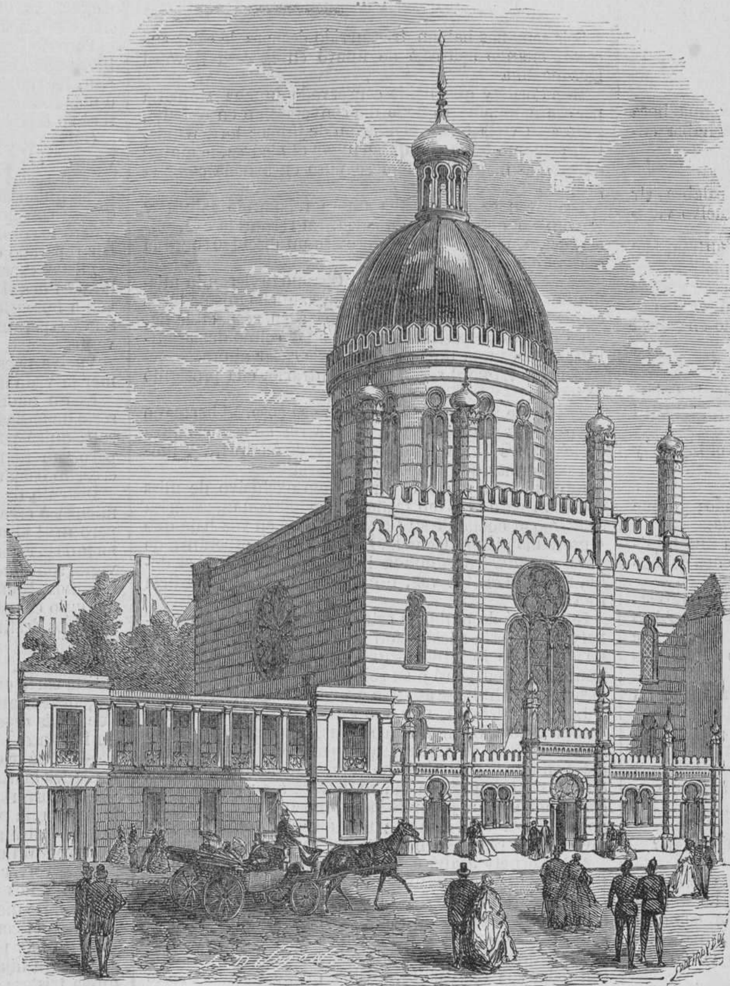
NUEVA SINAGOGA DE COLONIA, fundada bajo el patrocinio de M. Abraham Oppenheim, y construida por los planos de M. E. Zwirner, arquitecto de la catedral.
