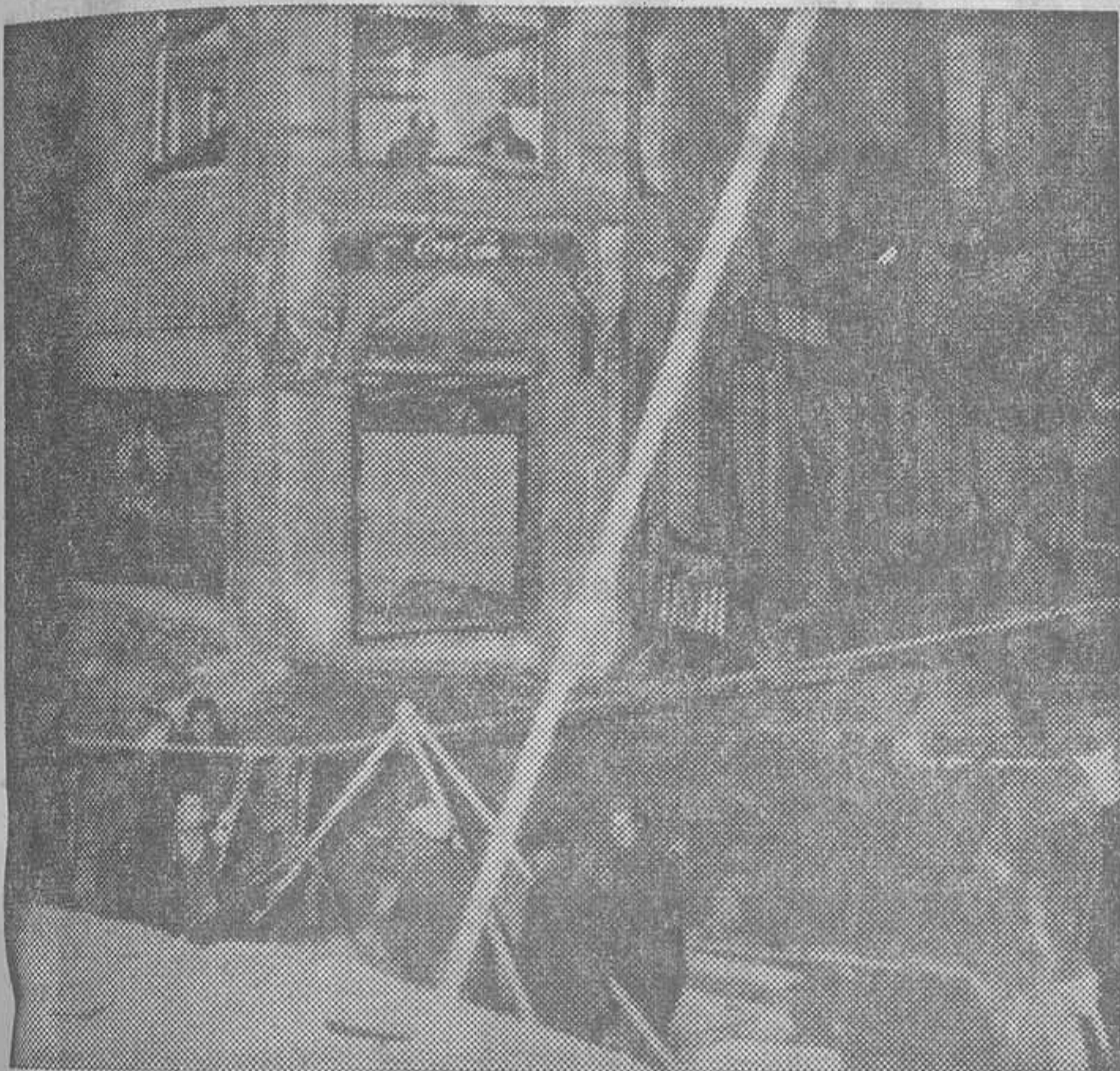
Estado en que quedó, tras ser apuntalada, la casa de San Gervasio afectada por el hundimiento de una mina de agua subterránea. En la parte inferior el socavón producido en el que perecieron dos personas. El hecho ocurrió hace diez años pero en cualquier momento podría volver a producirse.
