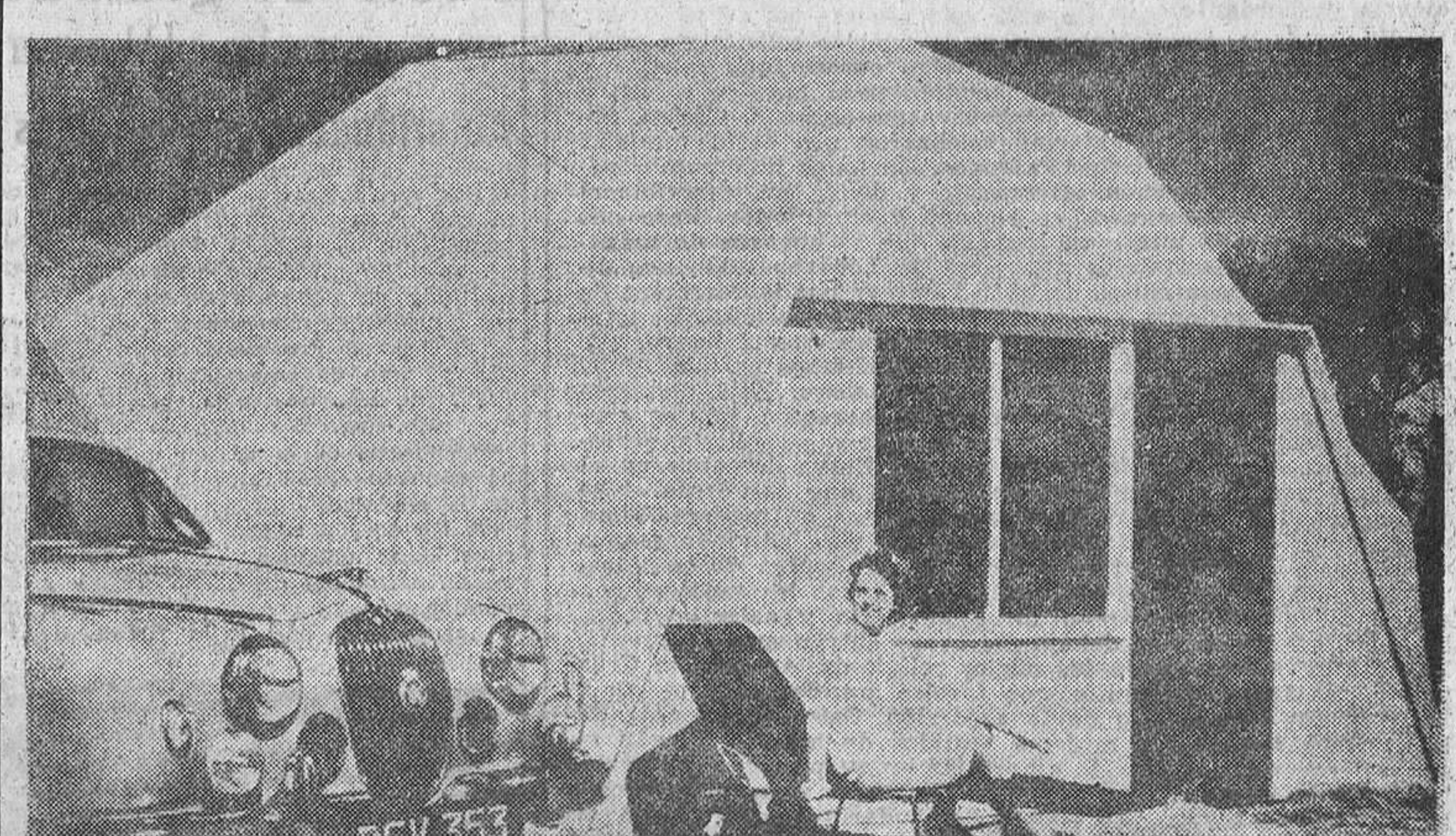
LONDRES.—Otro aspecto de la casa construida con paneles de plástico, que puede ser erigida o demolida en pocas horas. Mide ocho metros de diámetro y 3,5 metros de altura. — (Foto Cifra.)
