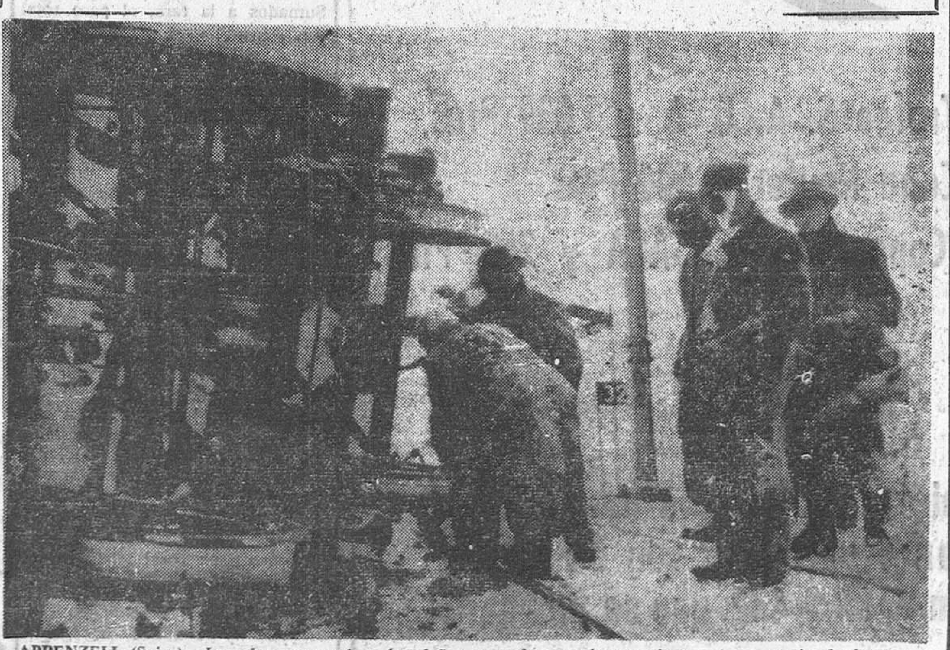
APPENZEL (Suiza).—Los obreros examinan los daños causados por fuertes vientos en un vagón de ferrocarril, volcado sobre las vías como consecuencia de la fuerza del temporal de aire.—(Foto Cifra)
