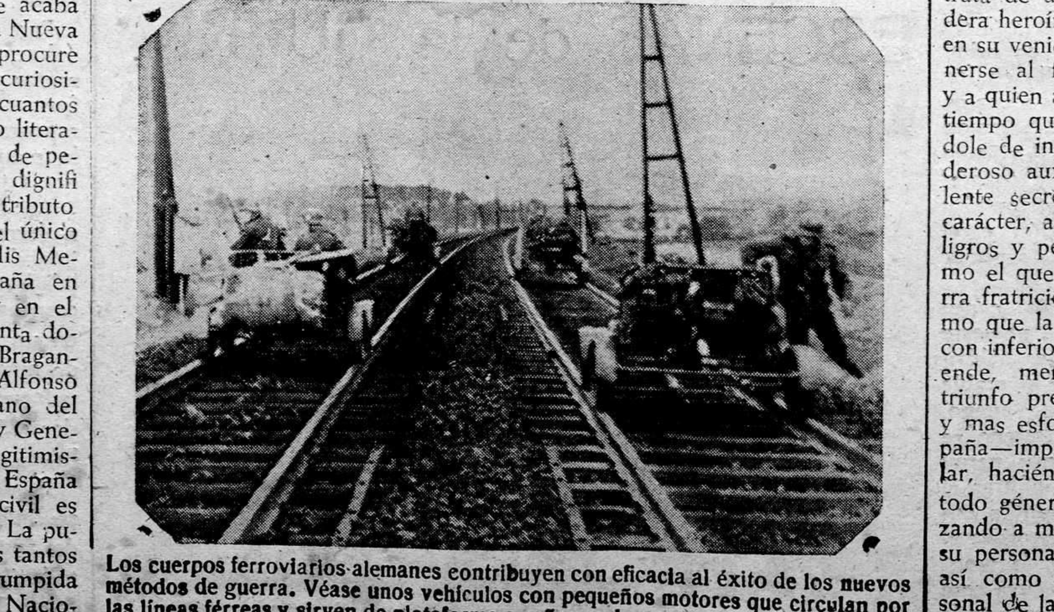
Los cuerpos ferroviarios alemanes contribuyen con eficacia al éxito de los nuevos métodos de guerra. Véase unos vehículos con pequeños motores que circulan por las líneas férreas y sirven de plataforma a cañones de poco calibre o ametralladoras
